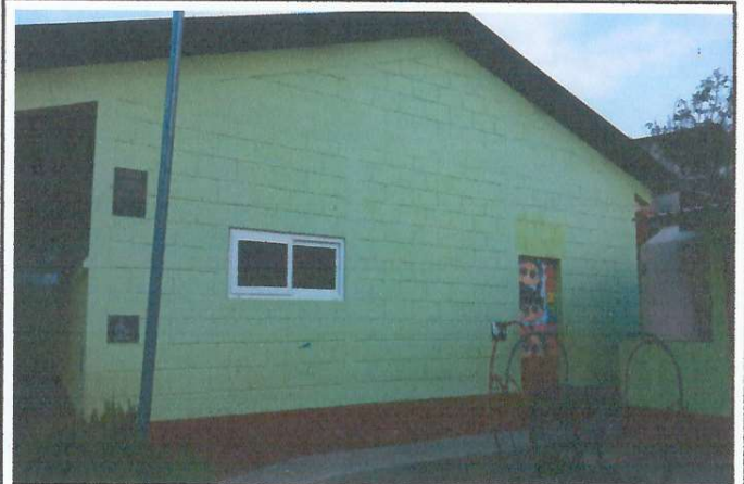
Foto 2: Mejoramiento de paredes
