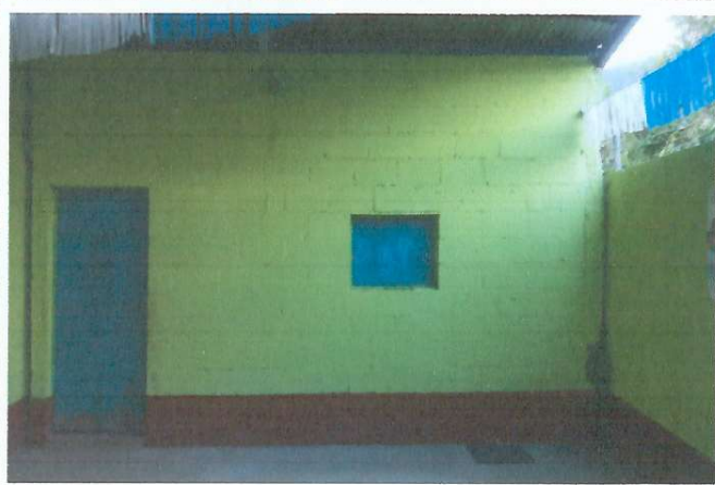
Foto 1: Mejoramiento estructura de cocina
